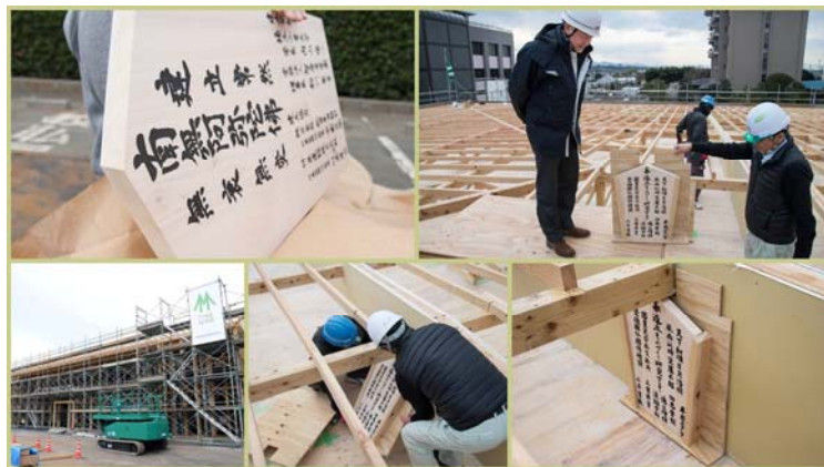
上棟式（平成 28 年 2 月 26 日）
